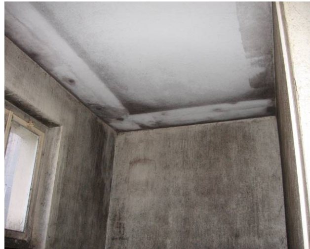
Rendkívül nagy mértékű penészgombás fertőzés
